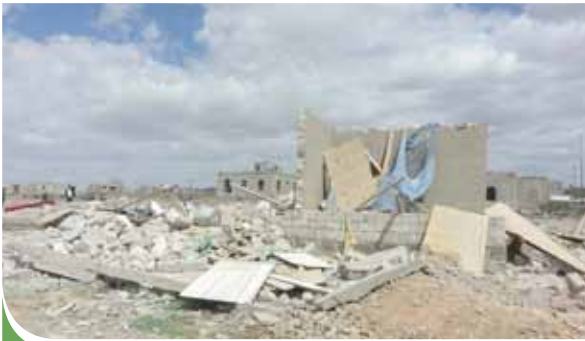
منزل دمره القصف في منطقة هران
