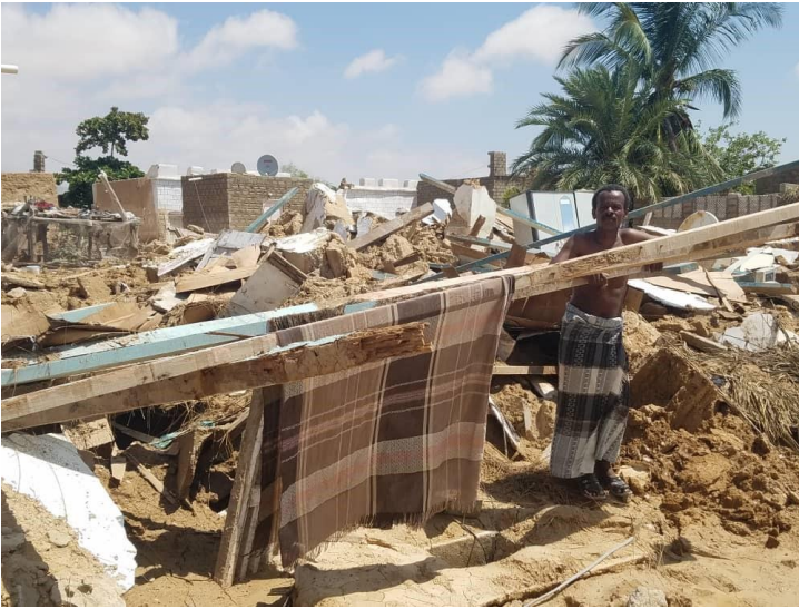
منزل متضرر في مديرية المسيلة بمحافظة المهرة. الصورة: الائتلاف للإغاثة الإنسانية
