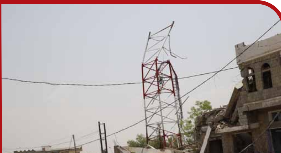
محطة وشبكة اتصالات حرص - محافظة حجة - قصفت بتاريخ ٢١/٤/٢٠١٥م
