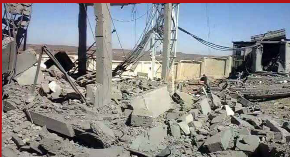
محطة وشبكة اتصالات الطفة - محافظة البيضاء - قصفت بتاريخ ١٦/٨/٢٠١٥م
