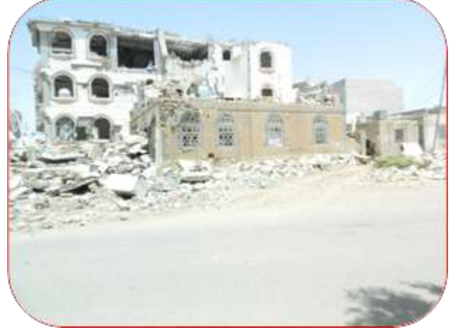
الدمار الذي لحق بمنزل فيصل الطشي جراء القصف
